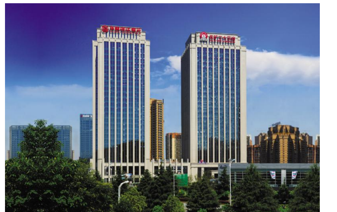
我司承建的万境财智中心工程项目荣获“中国建设工程鲁班奖”。
