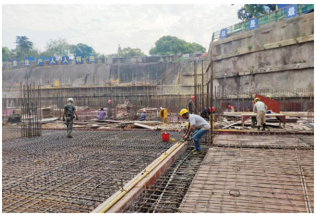
施工人员高温环境下作业。
