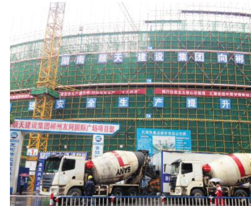
雨天进行砼浇捣 砼土搅拌车有序进入施工现场
